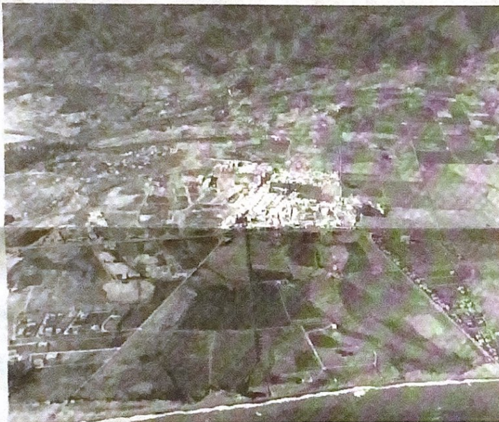
CONTRASTES. Vista aérea de la colonia en los años 50, donde se distingue la parcelación de los terrenos.
