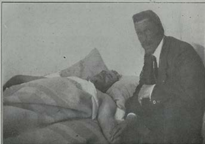
San Pedro Alcántara: El obrero Lorenzo Ramos, que sufrió la muerte al caer desde lo alto de la torre envuelto en los escombros
