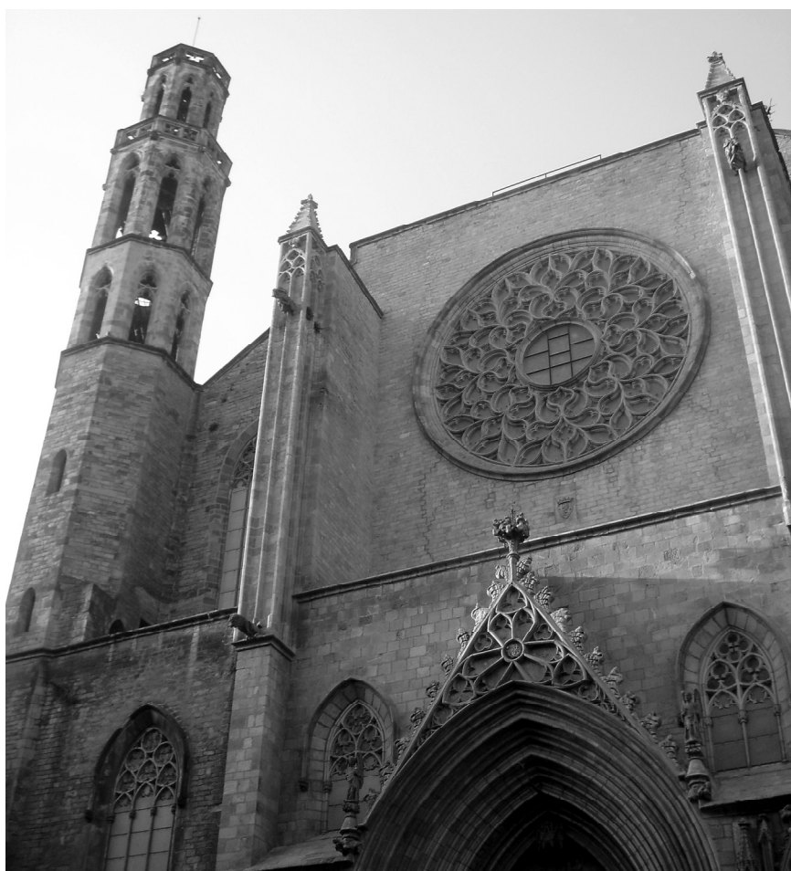
Fachada principal de Santa María del Mar
